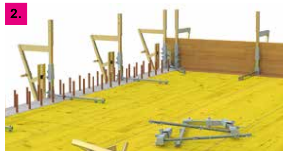
2. Erstellung der Deckenrandabschalung
