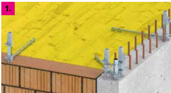
1. Aufnageln auf die Deckenschalung
