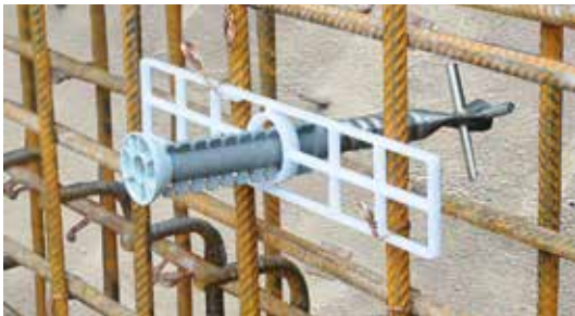
Ideal für die Verankerung einhäufiger Schalungen.
