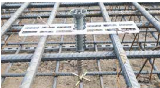
Bei Verwendung auf Decken- oder Bodenplatten wird der V2A UNI-Betonanker mit der Montageplatte auf die obere Bewehrung gebunden.
