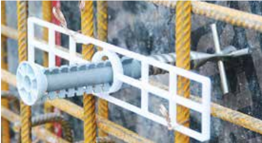
Bei Innenschalungen, Pfeiler- oder Stahlschalungen mit der Montageplatte an die Bewehrung binden.
