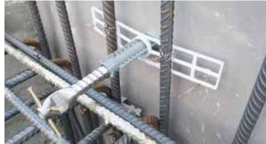
Über die Montageplatte wird der Konus optimal an die Schalhaut gepresst.
