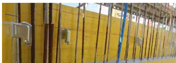
Sichere Montage der ASK Konsolenanker ohne zusätzliche Nägel.
