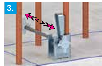
3. Distanzhalter auf die Markierung ausrichten
