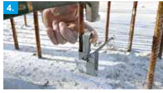
4. Anschlaghalterung mit dem Hammer fixieren
