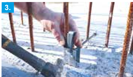
3. Distanzhalter auf die Markierung ausrichten
