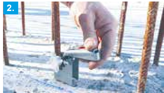
2. Der Keil positioniert sich automatisch
