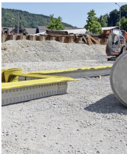
Einfaches und sicheres Verlegen des Fugenbandes mit dem V-Max Board WD garantiert die Dichtheit des Bauwerkes.
