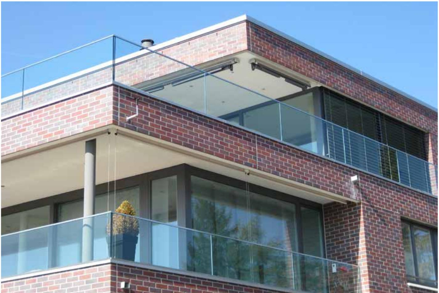
Das von ALBANESE® entwickelte Dachrand- und Terrassenabschlusssystem bietet dem Architekten eine einfache, stabile und sichere Lösung für kältebrückenfreie Flachdachränder und Terrassenabschlüsse, die allen ästhetischen Ansprüchen gerecht werden und den Bauablauf rationalisiert, vereinfacht und obendrein die Sicherheit erhöht. Teure Arbeitsschritte werden eliminiert, womit Kosten eingespart werden.
